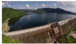
เขื่อนขุนด่านปราการชลสร้างจากคอนกรีตที่มีส่วนผสมของเถ้าลอย
