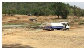
จัดพรมน้ำบริเวณถนนในพื้นที่ก่อสร้าง เพื่อลดการฟุ้งกระจายของฝุ่นละออง
