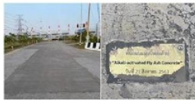
ถนนในโรงไฟฟ้าแม่เมาะซึ่งสร้างจากเถ้าลอยผสมน้ำ
