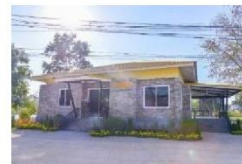
ใช้อิฐบล็อกประสานเพื่อสร้างอาคารต้นแบบจากเถ้าที่ได้จากโรงไฟฟ้า
