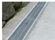
รางระบายน้ำ
