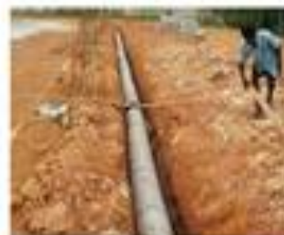
จัดทำรางระบายน้ำไปตามแนวถนน น้ำจากการก่อสร้างไม่ให้เกิดผลกระทบ ต่อพื้นที่โดยรอบ
